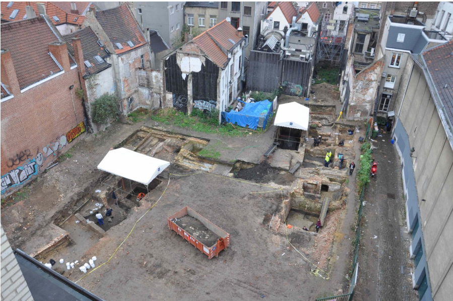
Fig. 4 : Vue d'ensemble du chantier de l'Îlot sacré ; photo prise depuis l'hôtel Aris. À droite, les caves et les fondations de maisons s'alignent sur l'impasse de la Tête de Bœuf. D'autres fondations apparaissent à gauche, à l'arrière du théâtre de Toone. L'ancienne rue d'Une Personne n'est dégagée que sur quelques mètres carrés, précisément au milieu du cliché (photo Sylvie Byl ©SPRB).
