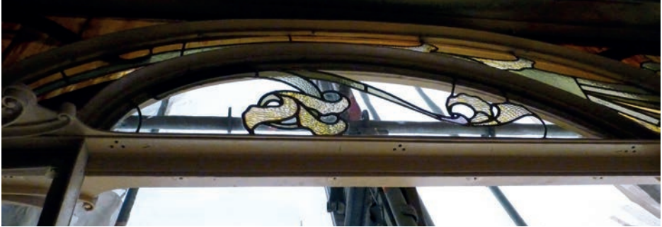
Fig. 2 - Détail des vitraux du lanterneau derrière un échafaudage installé pour le démontage de la serre.
