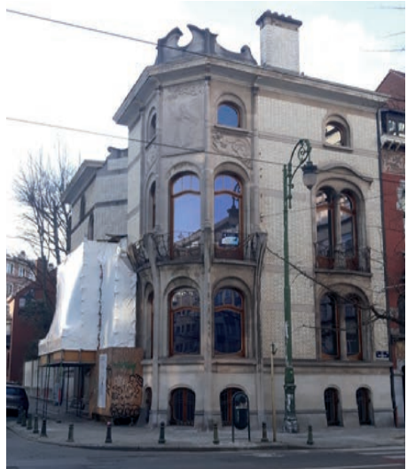
Fig. 1 - La maison Hannon en cours de restauration, vue depuis l'avenue Brugmann
