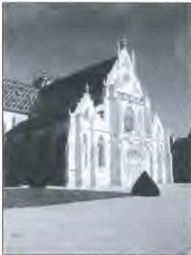
Fig.1 - Façade occidentale de l'église de Brou à Bourg-en-Bresse. (©Pan). L'église a fait l'objet de plusieurs restaurations ces dernières années. La modification et le renouvellement des toitures fut l'occasion de restituer les motifs décoratifs par des tuiles en terres cuites colorées. Le nettoyage de la façade eut lieu en 2005.
