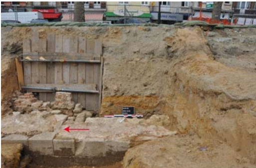
Fig. 6. Une couture verticale en « anglée » est apparue dans le blocage du mur des douves. Photo S. Byl © MRBC
