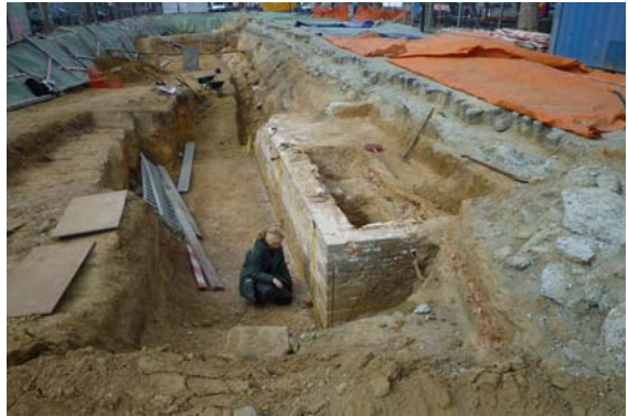
Fig. 4. L'un des deux pavillons qui encadraient l'entrée dans le domaine a été en partie mis au jour. Photo S. Byl © MRBC
