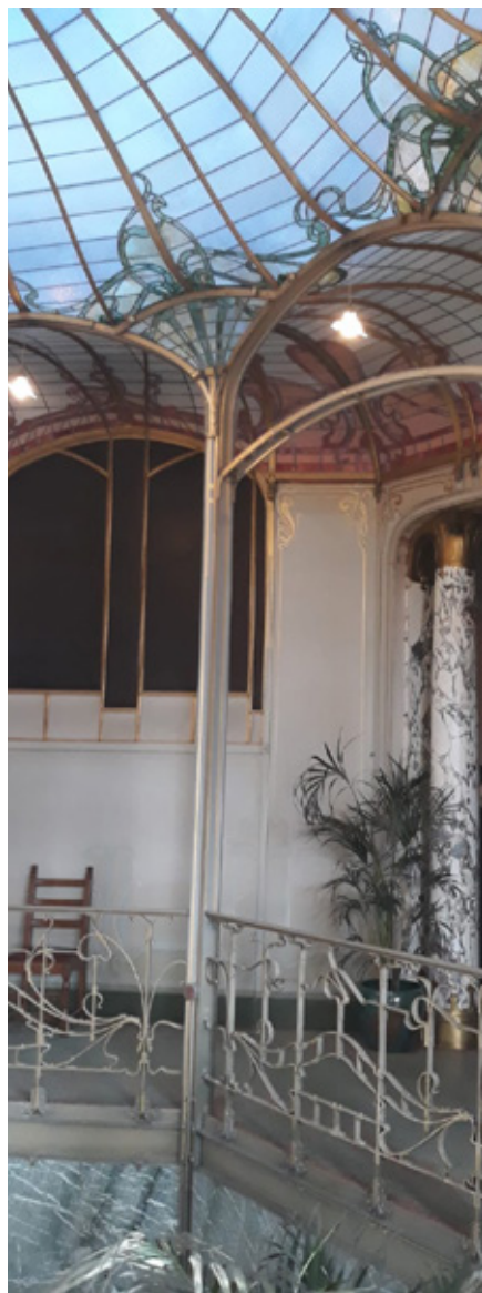
Fig. 5 – Verrière et supports de fer de la grande rotonde de la serre centrale de l'hôtel van Eetvelde. Précieux bijou d'architecture classée à l'Unesco, cet hôtel mérite à coup sûr une visite. © Pierre Anagnostopoulos, SRAB.
