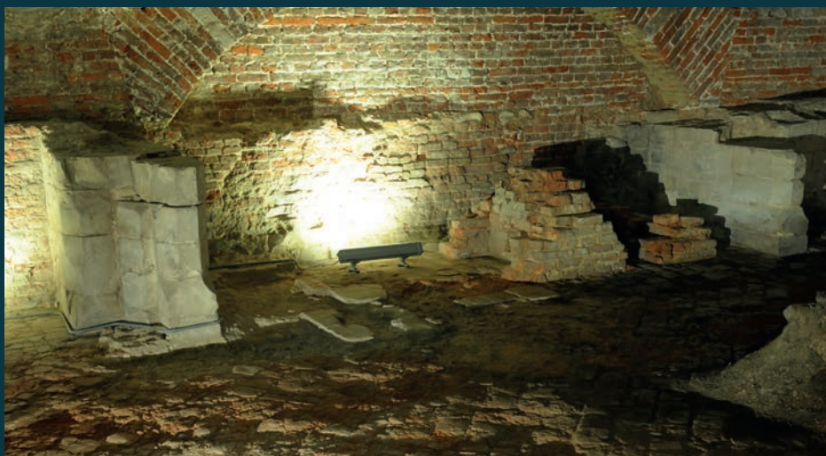
Fig. 12 - Vestiges du grand foyer encastré dans le mur pignon de la cuisine. Il comporte un fourneau en brique (Photo Marcel Vanhulst).
