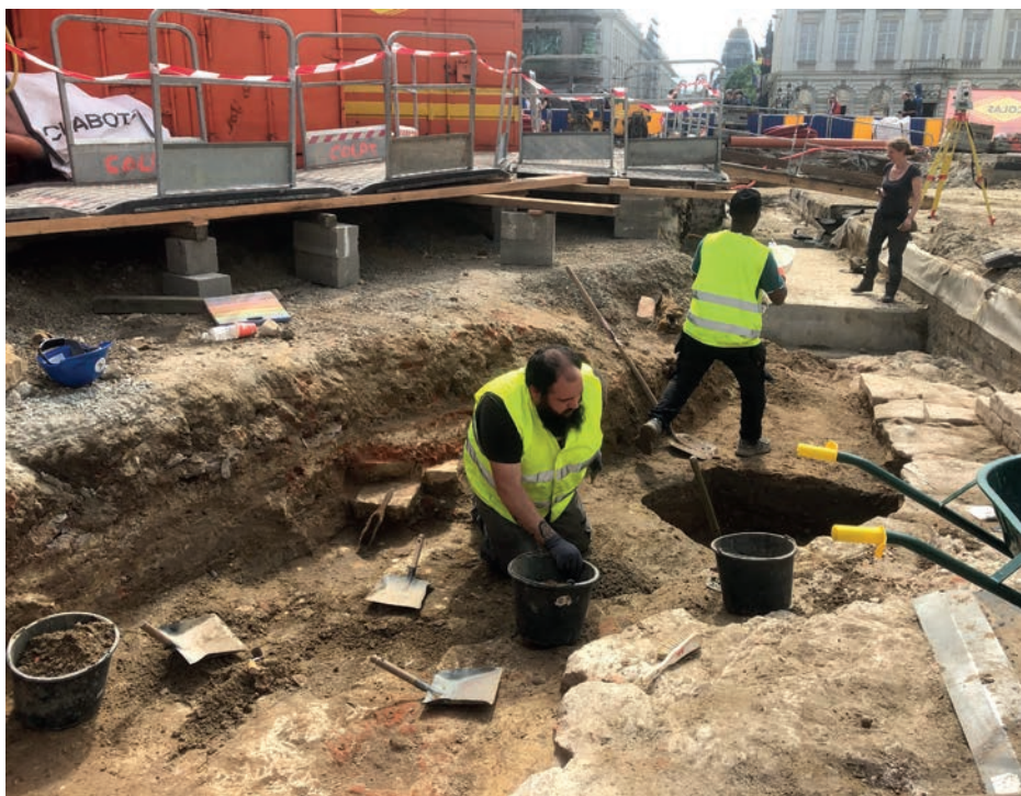
Fig. 1 : Une partie de l'équipe de la SRAB (Alessandro Giummarra et Mohammed Barry) sur le chantier de la place Royale, sous la direction de Julie Timmermans (pour urban. brussels), 30 avril 2024 (photo SRAB).
