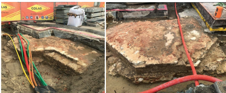
Fig. 2 & 3 : Fondations de la tourelle Sud-Ouest et de la tourelle Sud-Est de l' Aula magna (état au 27 mai 2024 ; photos SRAB).
